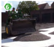
6 plaatsen van het grind
